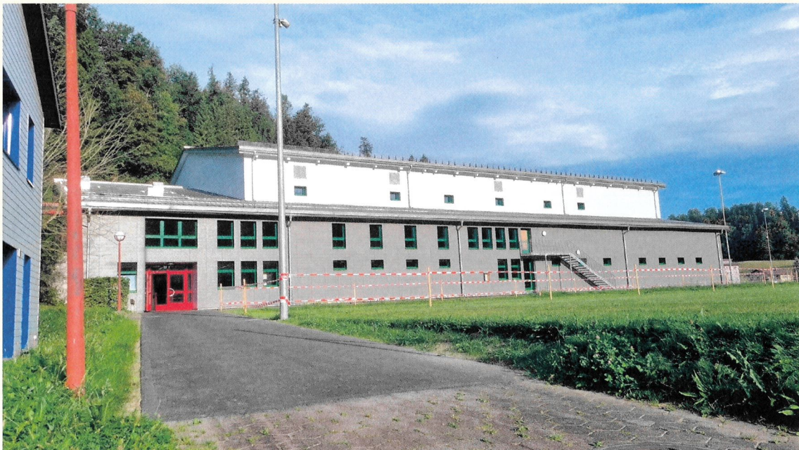
Die Sporthalle Berghof nach der Sanierung.
