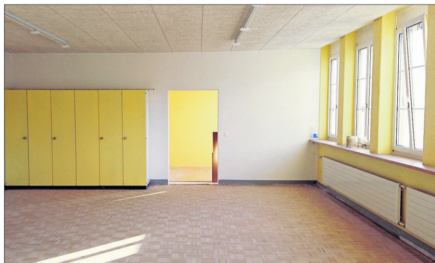
Sanierter Raum in einer Kindergartenabteilung mit neuer Decke und Durchgang.
